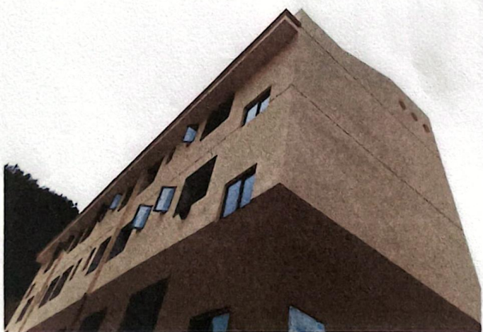
现场进度照片
