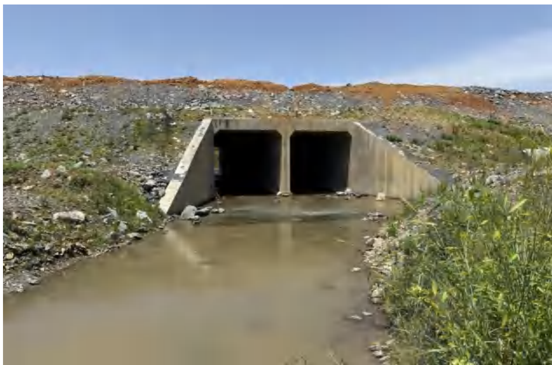
支路九桥涵进口照片
