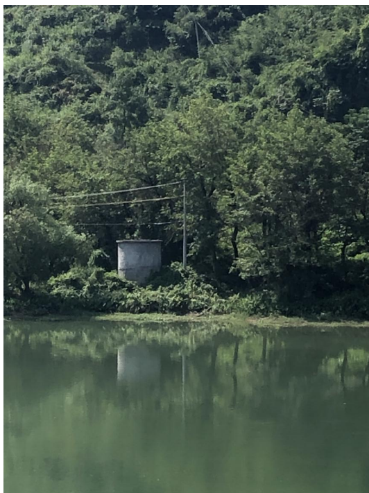
图2-4 木瓜水厂取水口及蓄水池现场图
