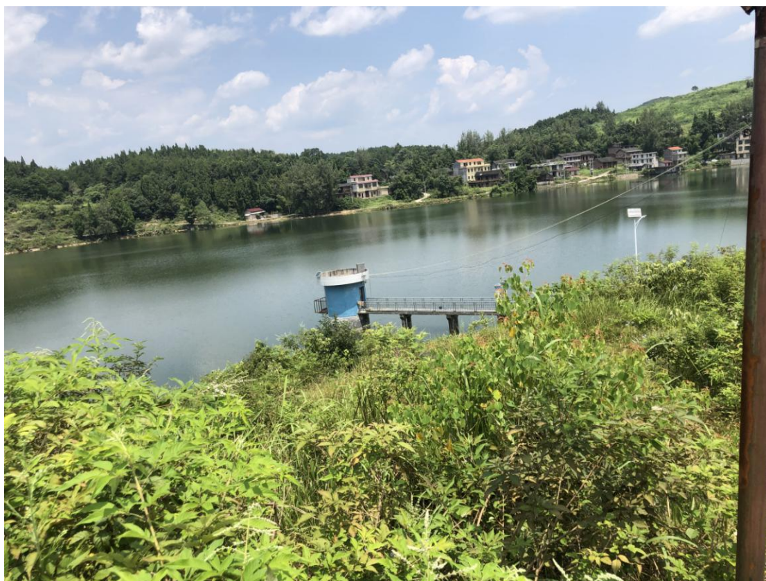
图 2-1 龙塘水厂取水口现场照片
