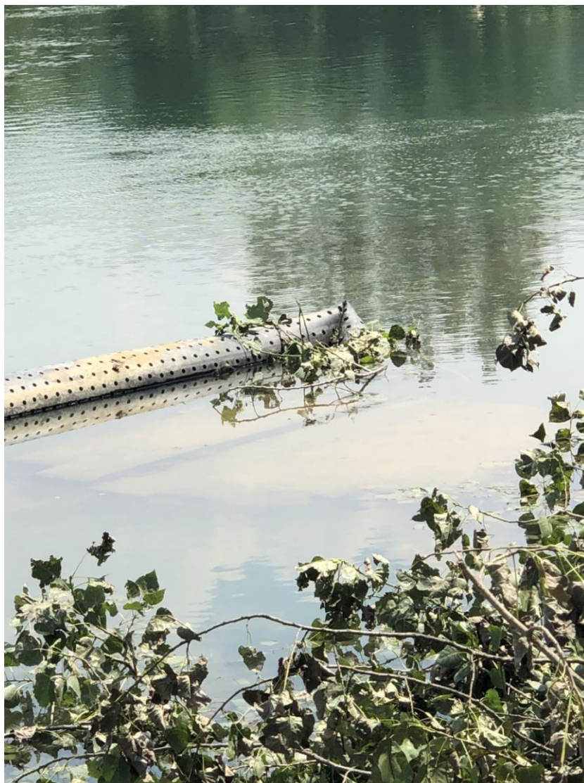
图 2-4 石江镇水厂取水口现场照片
