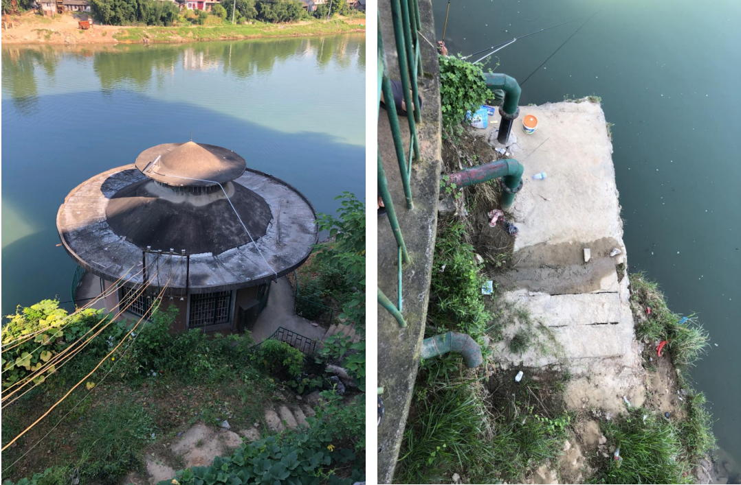
图 2-2 黄桥水厂取水口现场照片
