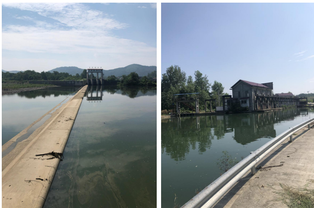
图 2-3 鸟竹园渠道引水坝及蓄水坝现场图
