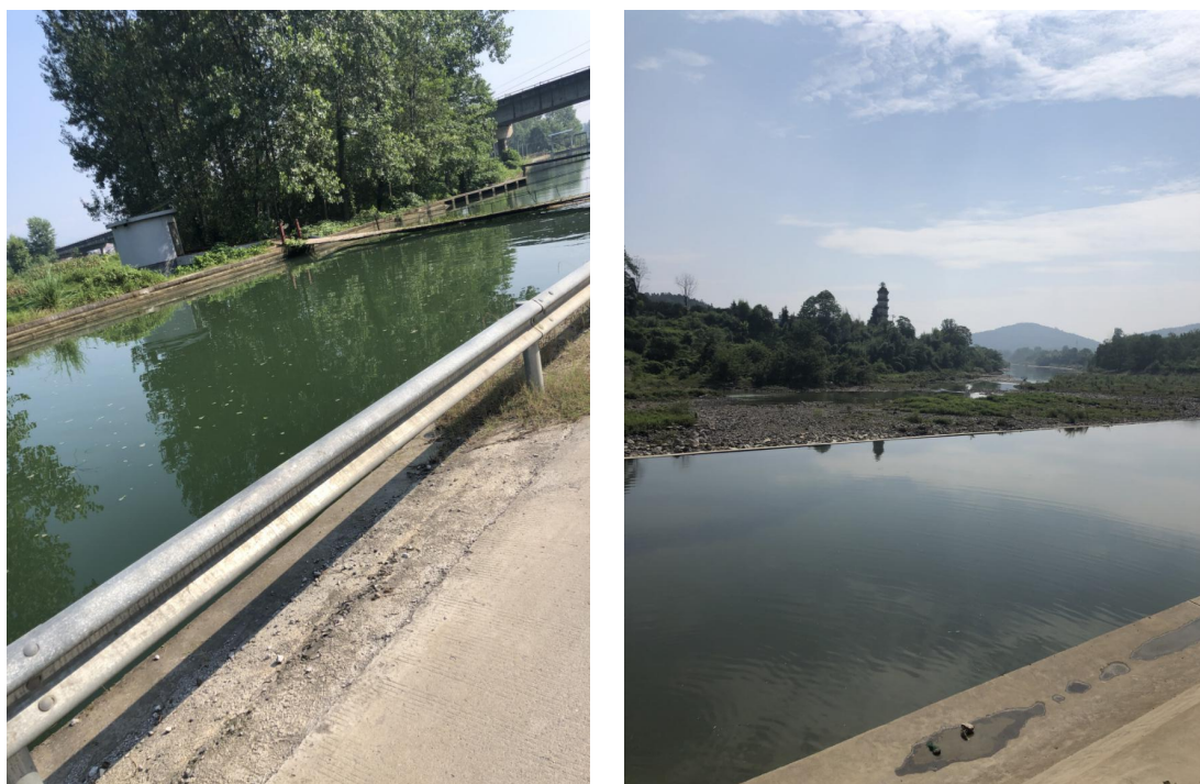
图 2-2 鸟竹园渠道及与平溪江汇水处现场图
