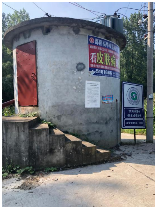
图2-5 乌竹园水厂取水口及蓄水池现场图
