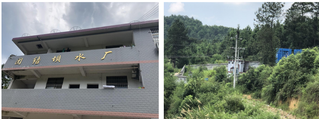
图2-3 团结坝水厂现场图
