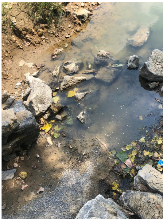
图2-4 团结坝水厂取水口现场图（河水通过人工堆置沙石过滤后流入蓄水池）
