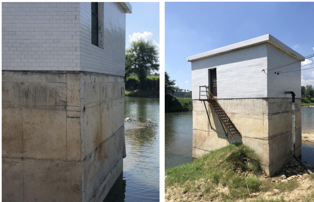
图2-4 西中水厂取水口及蓄水池现场图
