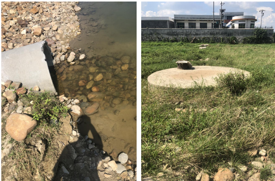
图2-4 高沙水厂取水口及蓄水池现场图
